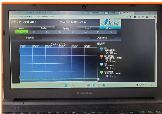
【火山ガス監視モニター】
