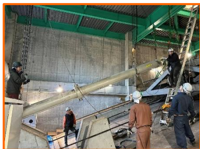
早雲山線 【緊張滑車軸組およびシリンダーの交換工事】
