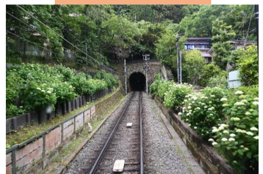
大平台トンネル前
