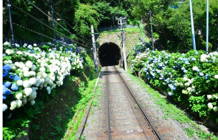
大平台トンネル前
