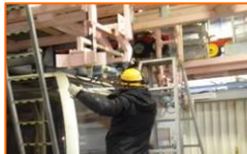
場内扉開扉装置整備
