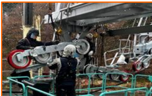
支柱受索装置整備
