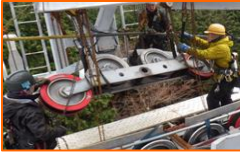
支柱受索装置整備
