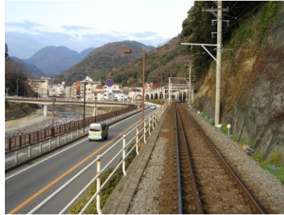
三線軌道(入生田車庫～箱根湯本)
